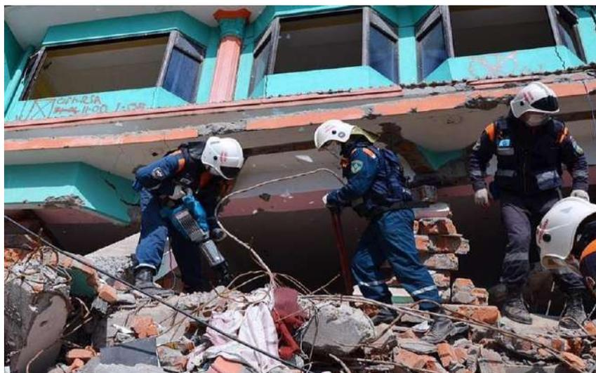
Рисунок. Разборка завала сверху осуществляется после обнаружения заваленного человека, укрепления неустойчивых обломков конструкции
